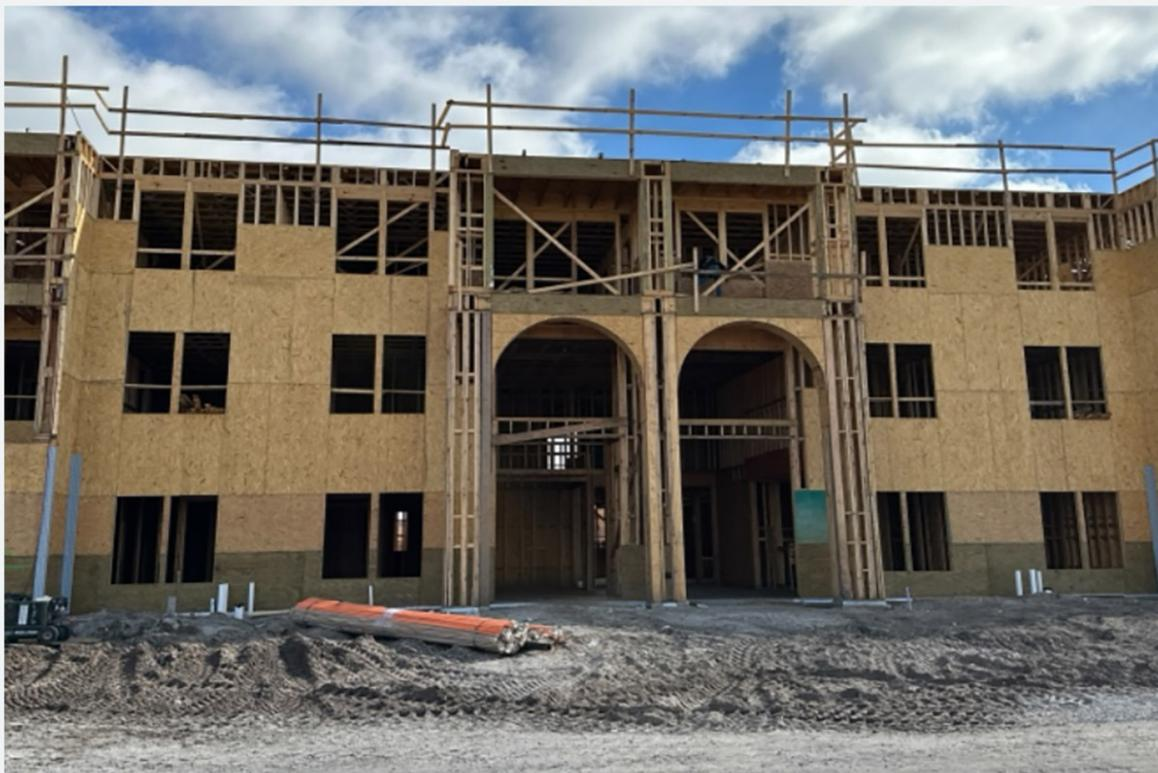
La estructura en los edificios de los townhouses 3 y 4 se ha finalizado y se ha instalado las bases del techo. La instalación de ventanas está en proceso. Las townhouses restantes, edificios 5 a 8, se encuentran a la altura del primer piso. Las
